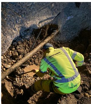
Strasse wird mit schwerem Gerät aufgerissen und das defekte Rohr gesucht.
