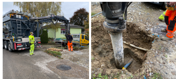
Saugbagger an der Arbeit Leitungsfreilegung
